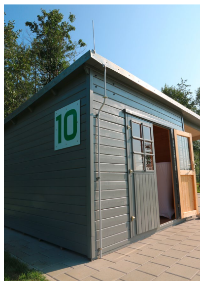
Schutzhütte mit hochspannungsfester isolierter Ableitung
